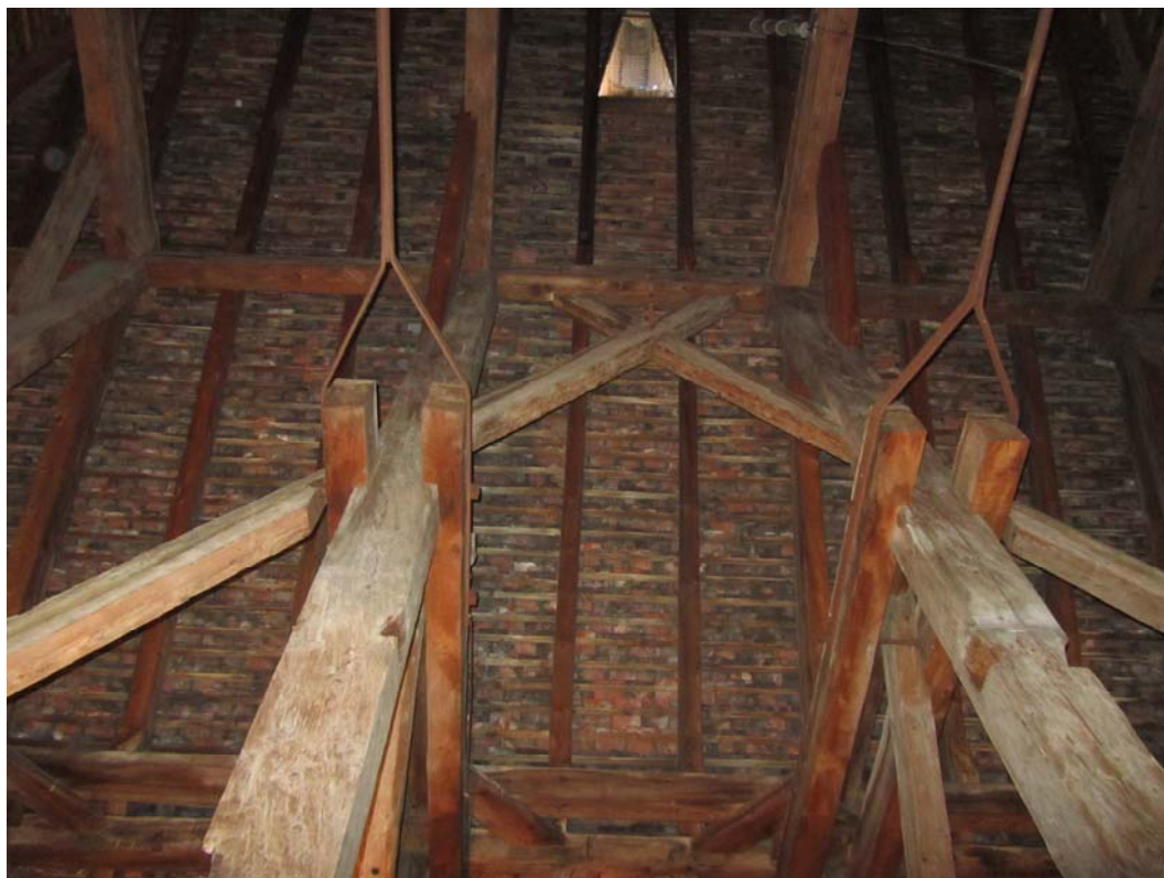
Une visite des combles après avoir gravité des escaliers relativement raides, ne nous fera pas de mal. C'est ici en vérité un endroit magnifique où l'on resterait longtemps à écouter les rumeurs de la ville.
